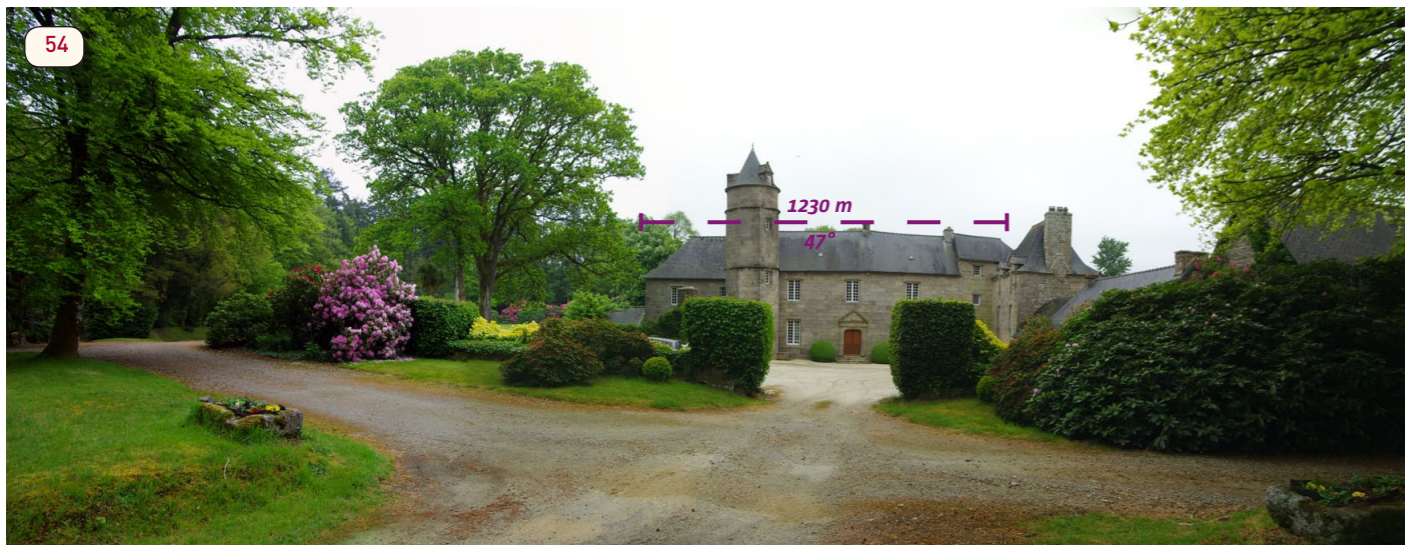
Le manoir du Helloc'h (commune de Bourbriac) est situé à l'arrière d'un boisement qui tronque fortement les vues en direction du secteur du projet. Depuis l'accès principal (photo ci-dessus), le bâtiment principal tronque également la vue. Un photomontage viendra préciser la perception.
