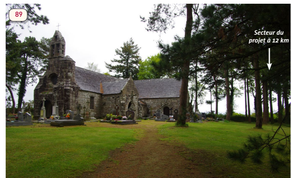
Chapelle de Burthulet (MH59) : au-delà des arbres qui entourent la chapelle, la vue en direction du secteur du projet est masquée par des haies d'arbres persistants. Pas de covisibilité potentielle.
